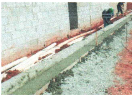
Execução de Sarjeta Moldada in-loco.
