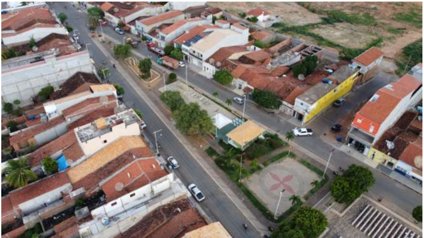
Figura 3. Local da obra - Imagem Posterior Esquerda
