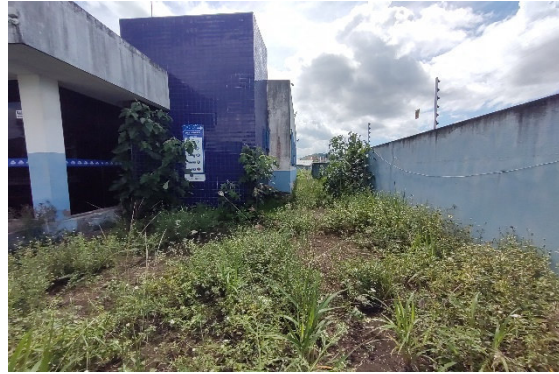
FOTO-2- AREA EXTERNA/ LATERAL
