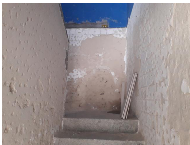
Foto nº 14: Escada acesso ao auditório.
