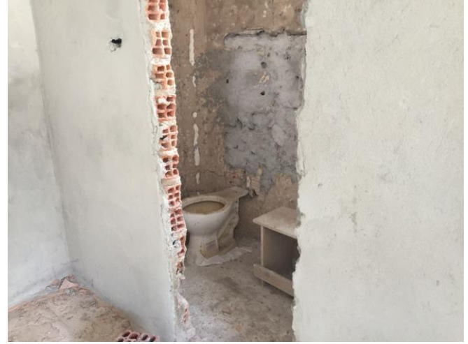
Foto 2: Revestimentos (Chapisco e reboco).
