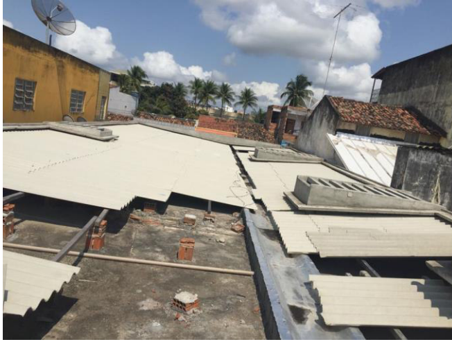
Foto 1: Cobertura em telhas de fibrocimento.
