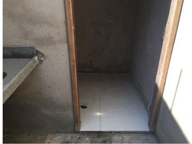
Foto 2: Revestimento cerâmico e Porta em madeira.
