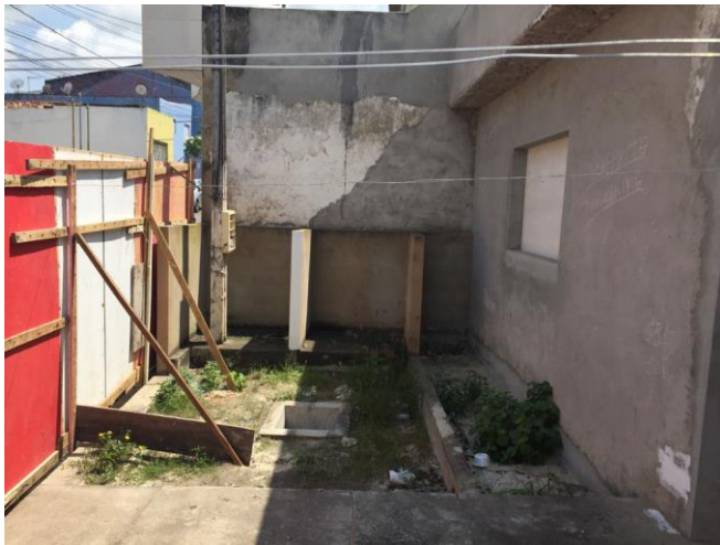
Foto 3: Fachada do prédio.
