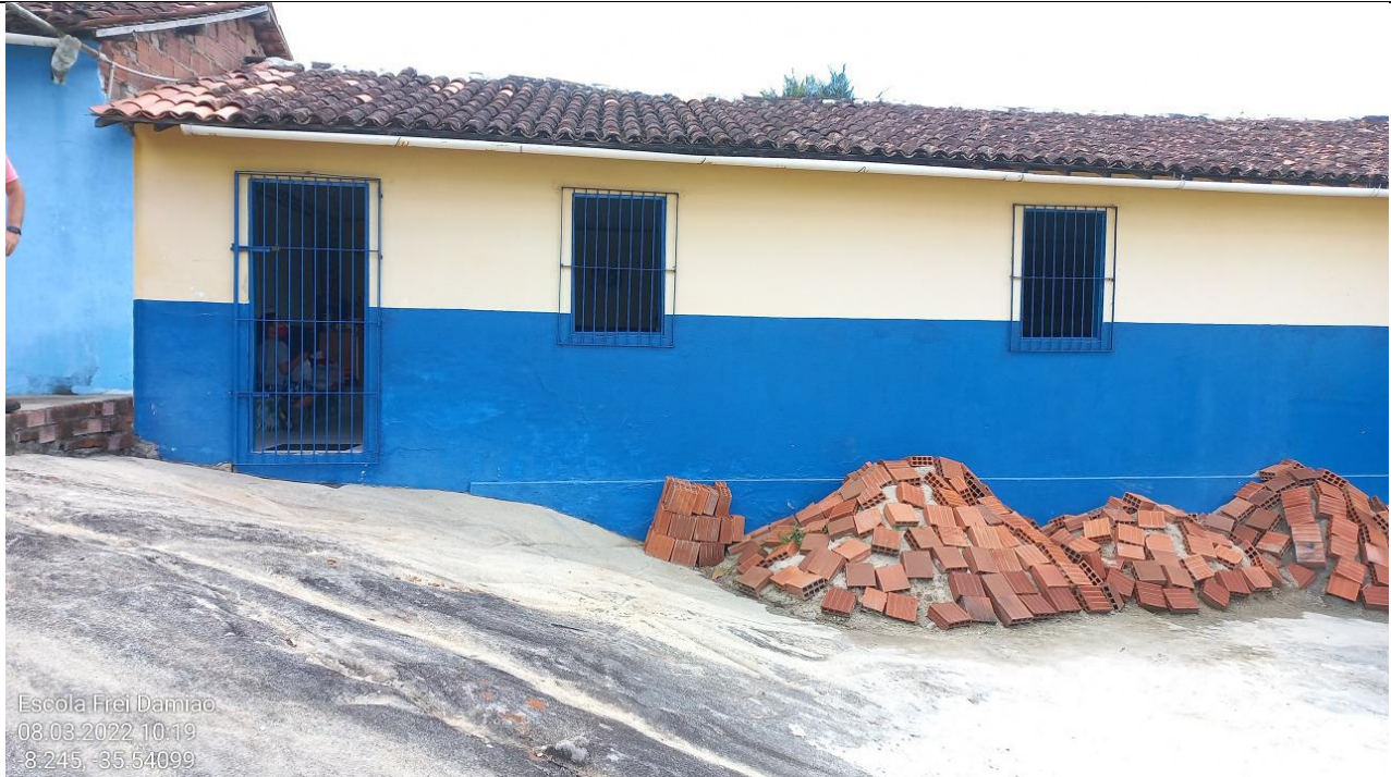
Escola Municipal Frei Damião de Bozzano – Acesso as salas de aula.
