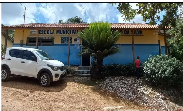
Escola Manoel Francisco – Fachada Principal.
