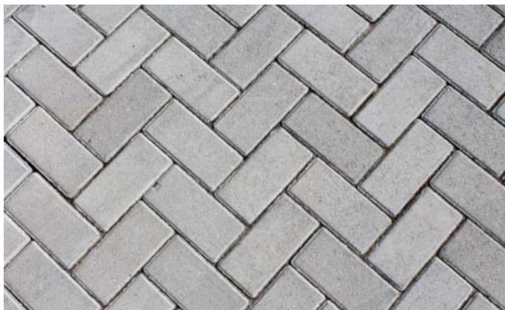
*Figura 4 - Exemplo de piso intertravado. Fonte: Escola Engenharia*
