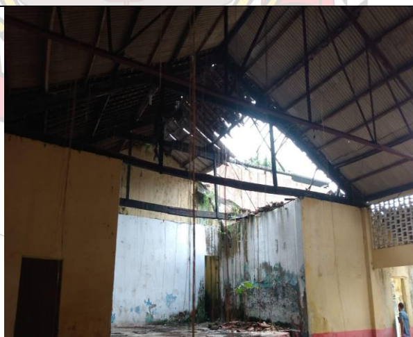
FOTO 08: revisão geral da estrutura de cobertura
