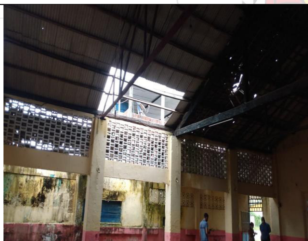
FOTO 07: pintura geral em todas áreas internas e externas, e, remoção do reboco com infiltração.
