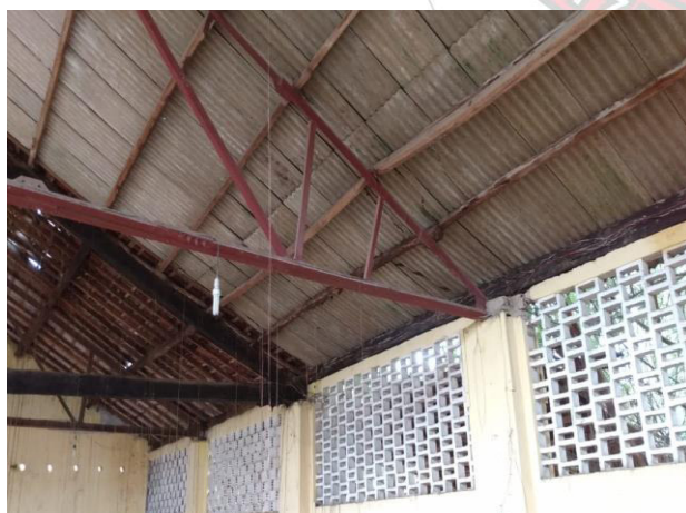
FOTO 03: substituição de todas as telhas (canal / fibrocimento ).
