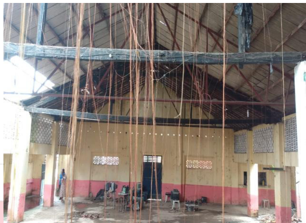
FOTO 05: remover e substituir 03 tesouras de madeira existentes.
