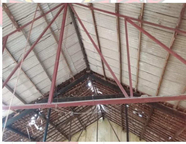
FOTO 04: recuperar e pintura duas tesouras metálicas existentes.
