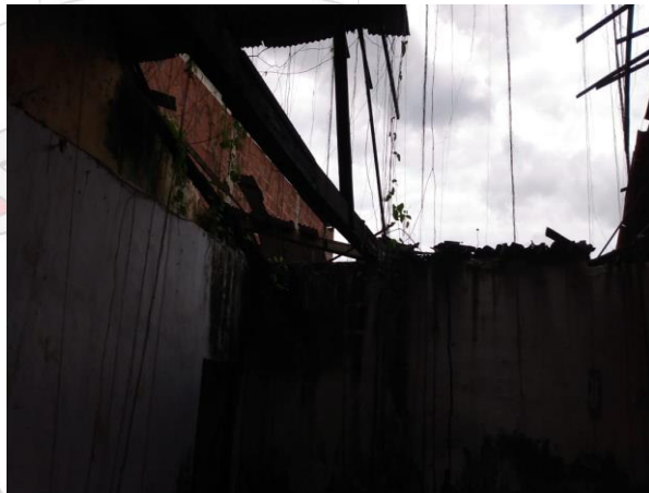
FOTO 06: lateral do prédio totalmente destruído.
