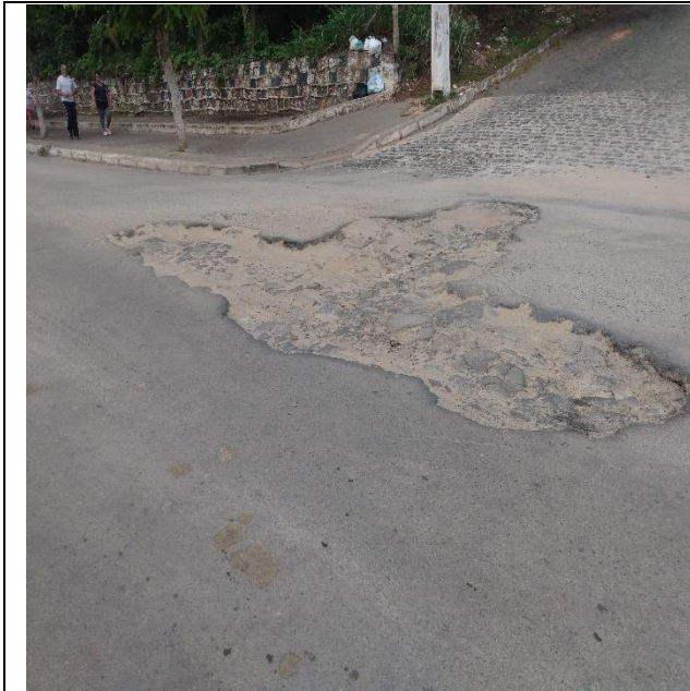
FOTO 17: RUA VISCONDE DE UTINGA – CENTRO
