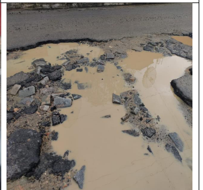
FOTO 12: RUA BARÃO DE UTINGA – VILA OPERARIA
