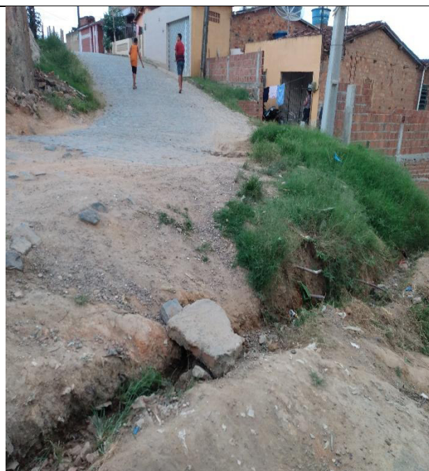
FOTO 42: RUA DA ESPERANÇA – BATE ESTACA
