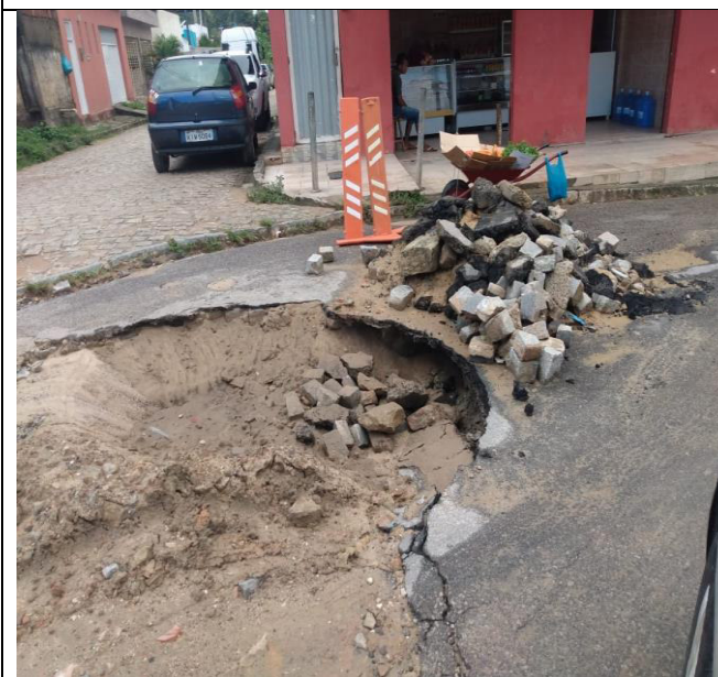
FOTO 11: RUA BARÃO DE UTINGA – VILA OPERARIA
