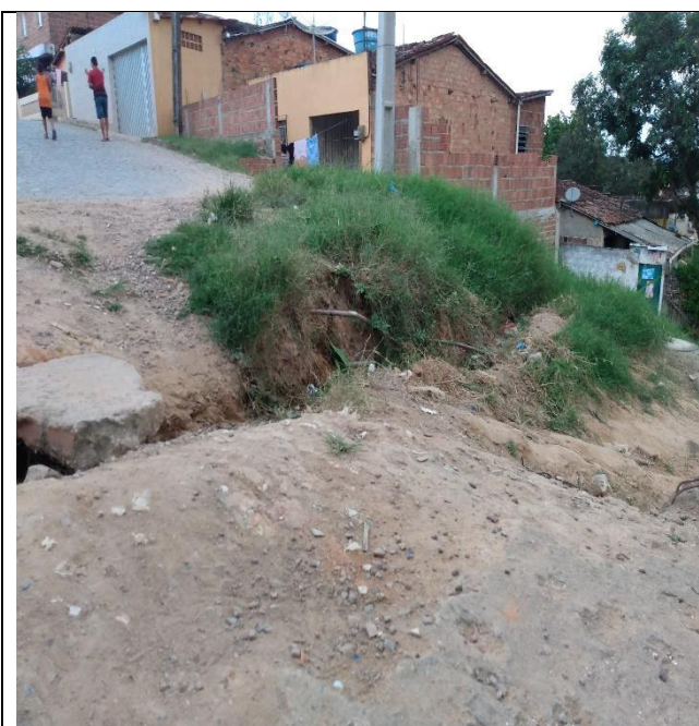
FOTO 43: RUA DA ESPERANÇA – BATE ESTACA
