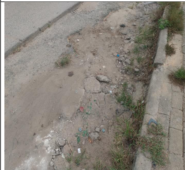
FOTO 15: RUA JOSÉ PEREIRA/ DANTAS BARRETO - MARACUJÁ
