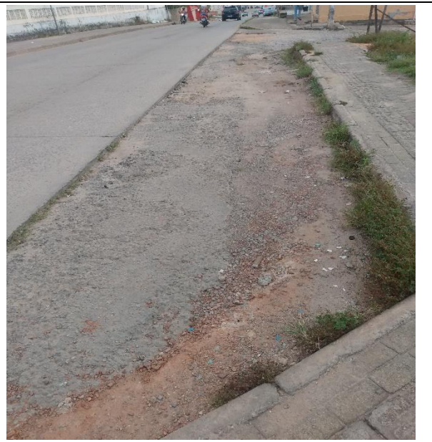
FOTO 14: RUA JOSÉ PEREIRA/ DANTAS BARRETO - MARACUJÁ
