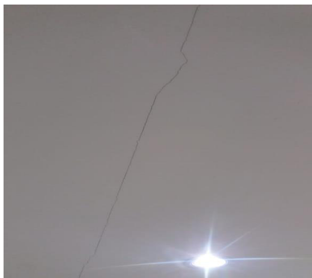
FOTO 03: REVISÃO DE PINTURA
