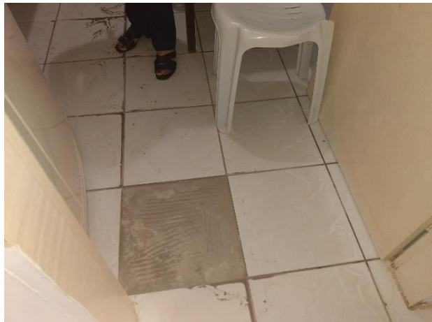
FOTO 09: SUBSTITUIÇÃO DE PISO CERÂMICO EM TODO PRÉDIO
