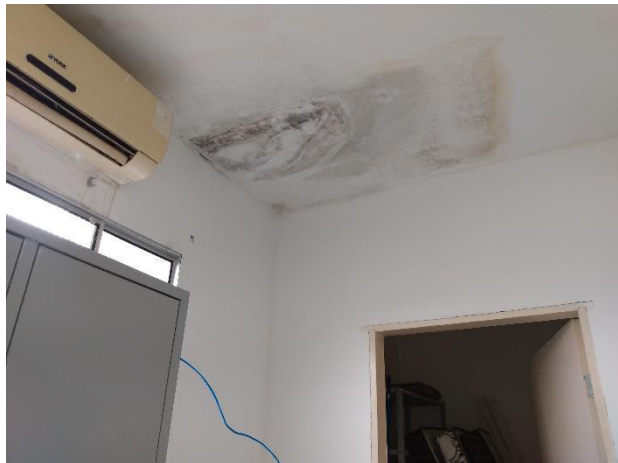
FOTO 05: FORRO DE GESSO DANIFICADO - PINTURA GERAL EM TODO FORRO
