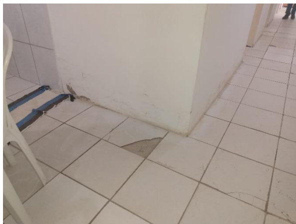
FOTO 10: SUBSTITUIÇÃO DE PISO CERÂMICO EM TODO PRÉDIO
