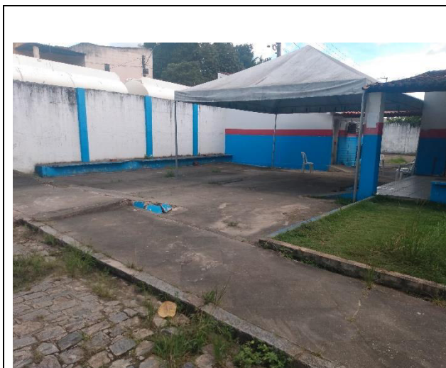
FOTO 01: ÁREA DE AMPLIAÇÃO DA ESPERA
